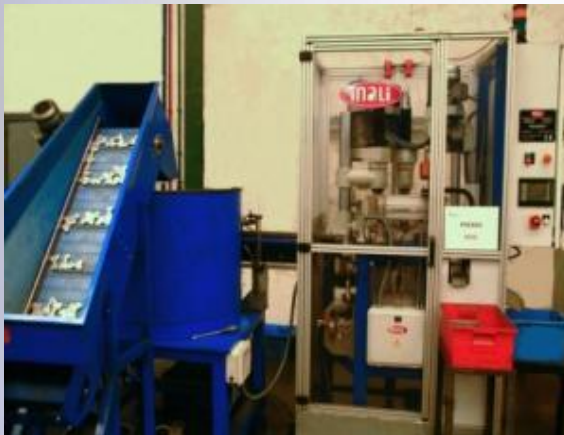
Azpiaran Berriz Plant
