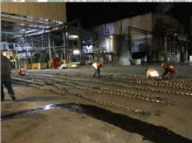
MANTENIMIENTO A LINEAS DE PROCESO
