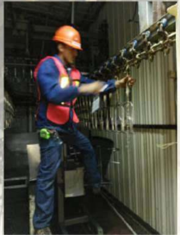
MANTENIMIENTO A LINEAS DE PROCESO
