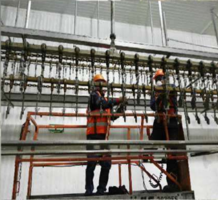
MANTENIMIENTO A LINEAS DE PROCESO
