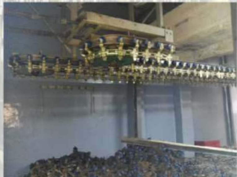
MANTENIMIENTO A LINEAS DE PROCESO
